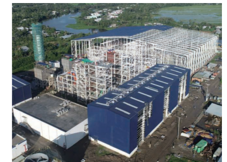
建設途中のハウジャンバイオマス発電所
